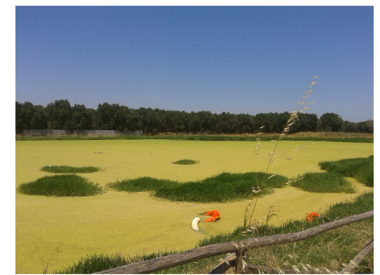
Fig.4: Trincee drenanti - recapito finale dell'impianto di depurazione di Squinzano (LE)
