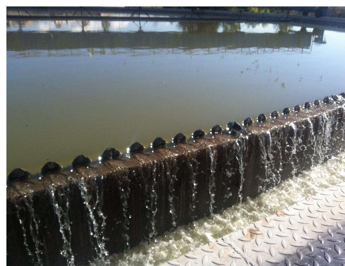
Fig.3: Sedimentazione finale nell'impianto di depurazione di Taranto Gennarini (TA)
