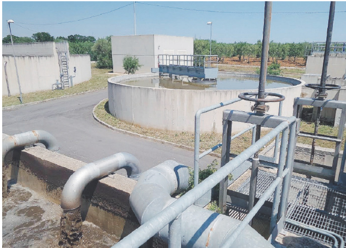
CASSANO Il depuratore dell'Acquedotto pugliese inaugurato in contrada Malatesta
