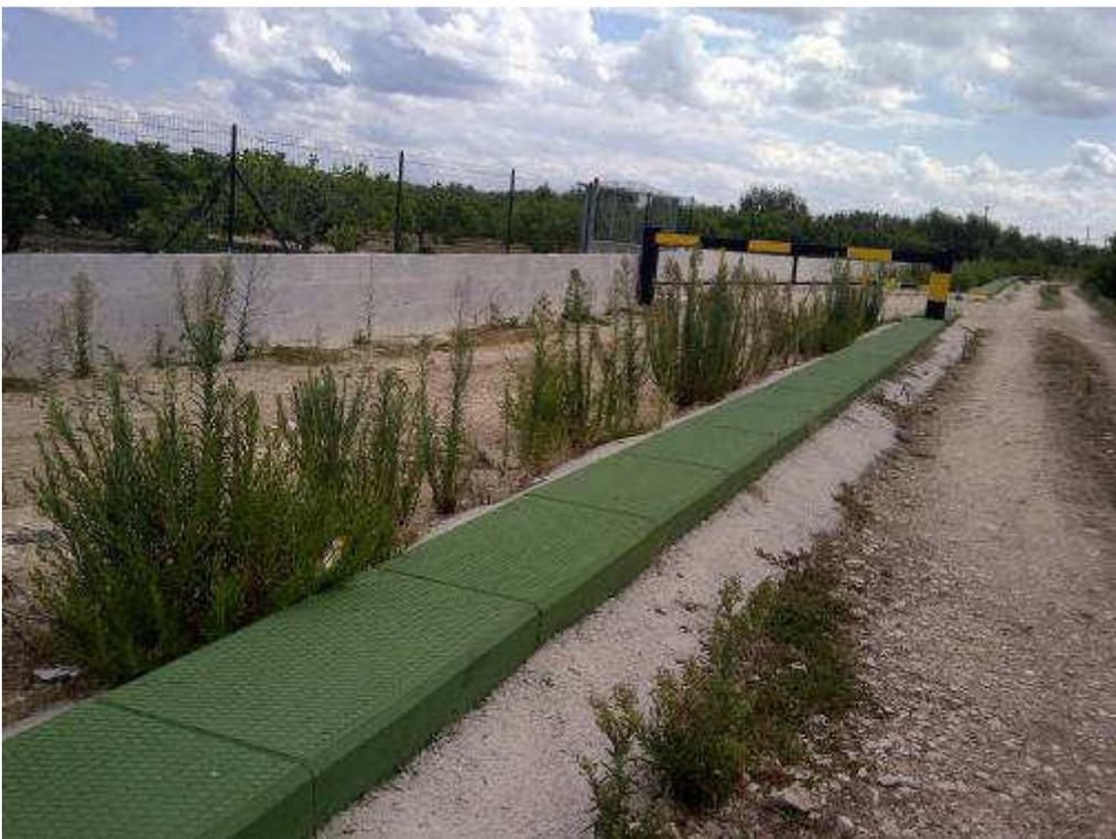
**Fotografia n. 7:** Le fotografie ritraggono le nuove opere realizzate da Aqp nel 2012 e relative alla condotta per convogliare i reflui depurati di Bisceglie alla stazione di sollevamento, prevista nei pressi di Torre Calderina, a servizio della condotta sottomarina. Le fotografie sono state scattate nel territorio del Comune di Molfetta, nell'Oasi di Protezione Torre Calderina nel tratto compreso tra il litorale e la SS16 Molfetta-Bisceglie.
